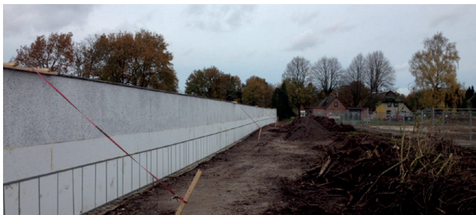
Afbeelding 4: Aanbrengen bovenste EPS-blokken, afdekplaten en afschoren
