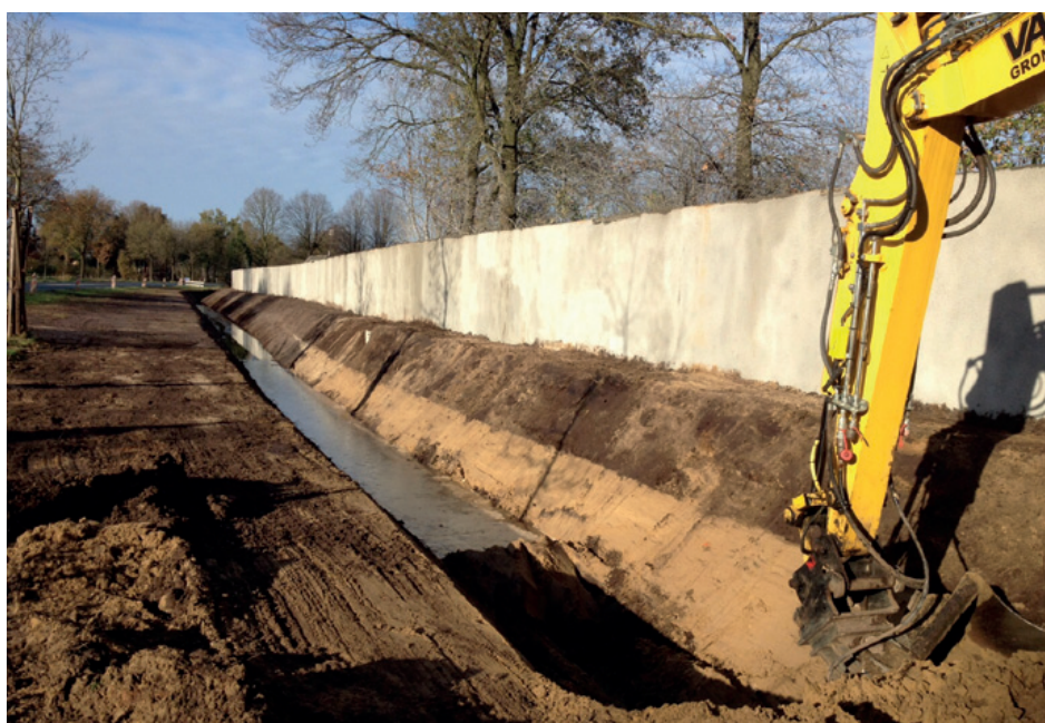
Afbeelding 6: Ontgraven sloot
