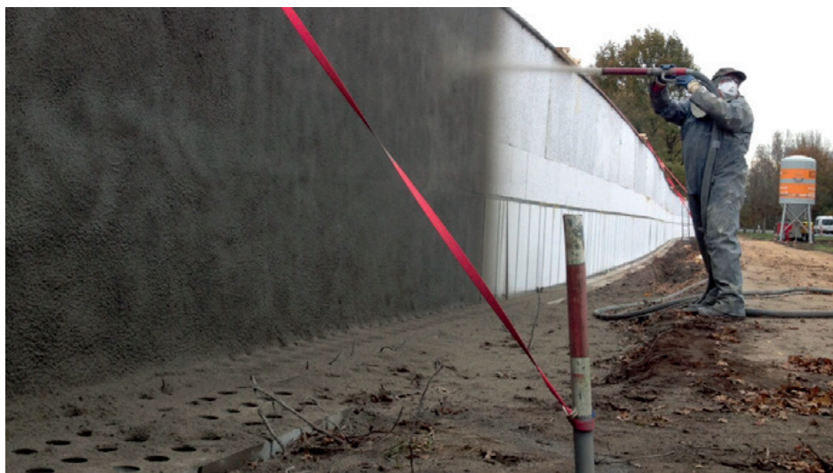
Afbeelding 5: Aanbrengen spuitbeton
