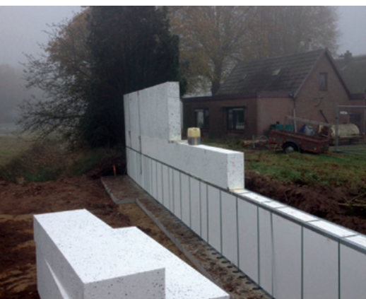
Afbeelding 3: Aanbrengen bovenste EPS-blokken (schermbeëindiging)
