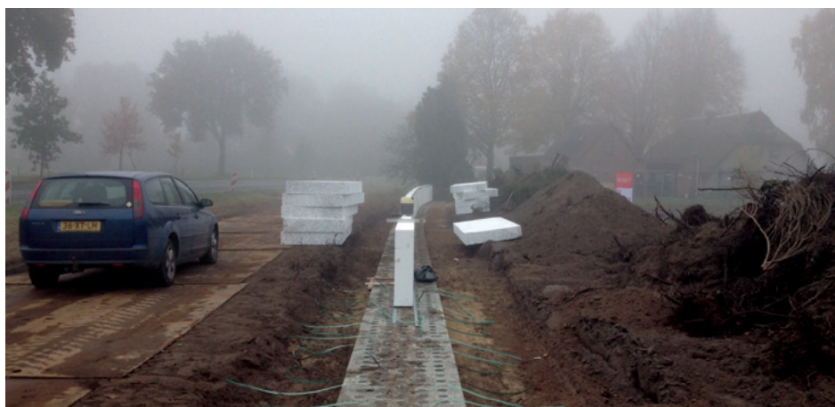
Afbeelding 2: Aanleg Simgrasplaten, spanbanden en onderste EPS-blokken
