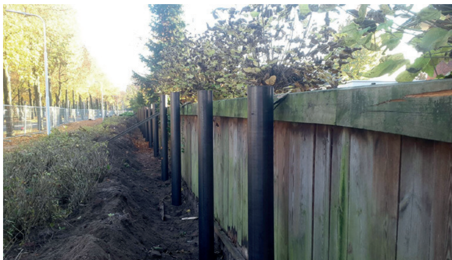
Afbeelding 3: Aanbrengen open stalen buispalen achter bestaand scherm
