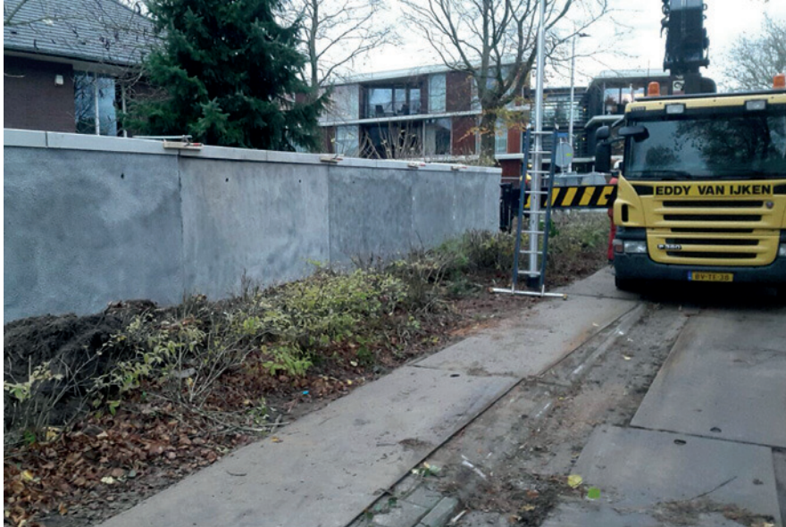
Afbeelding 6: Geplaatste geprefabriceerde schermdelen
