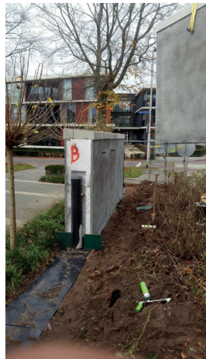
Afbeelding 5: Plaatsing geprefabriceerde schermdelen op palen
