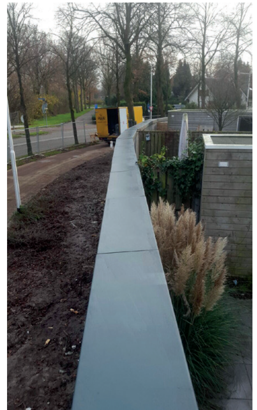
Afbeelding 7: Plaatsing scherm zonder schade aan bewonerszijde
