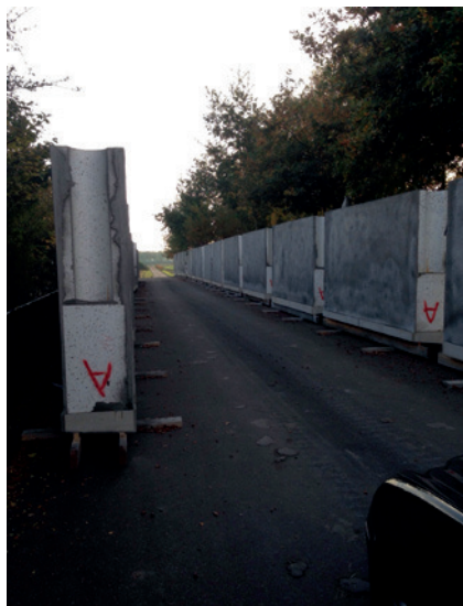
Afbeelding 4: Geprefabriceerde schermdelen voor transport
